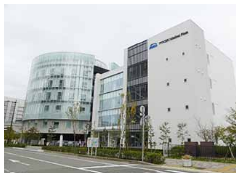
伊藤忠医疗广场外观
