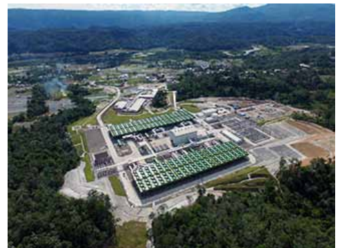
沙鲁拉地热发电站1号机组
