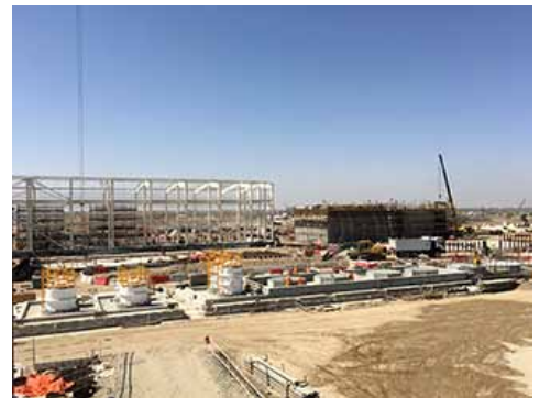
海水淡化工厂（建设中）
