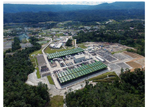
沙鲁拉地热发电站1号机组
