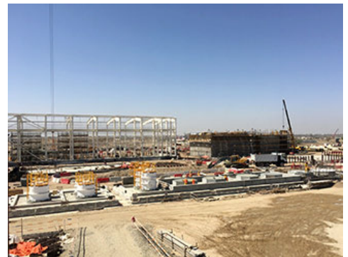
海水淡化工厂（建设中）
