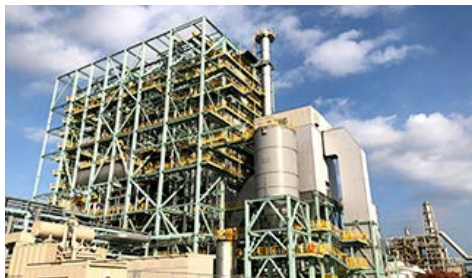
市原バイオマス発電所
