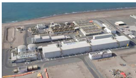
海水淡水化プラント
