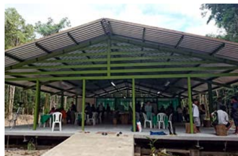
完成したフィールドステーション
