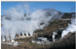
九州电力株式会社 八丁原双循环发电设备 (2000kw)
