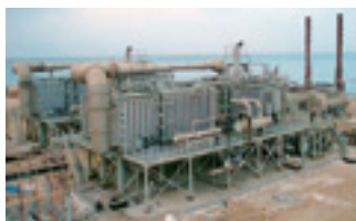
建设中的海水淡化化设备（沙特阿拉伯）
