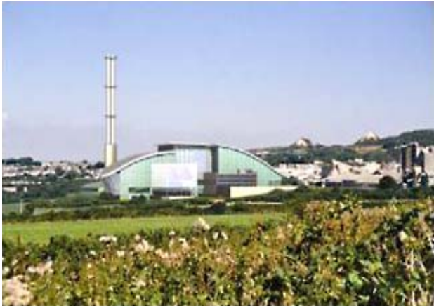
康威尔废弃物焚烧发电站
