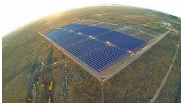
在建设中的第一期招标事业的75万MW太阳能发电系统
