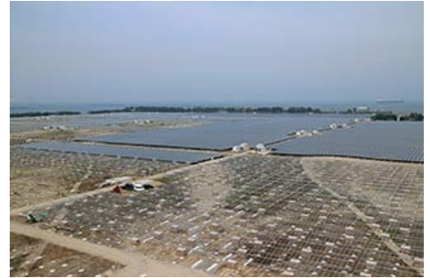
顺利进行建设的大分兆瓦级光伏电站
