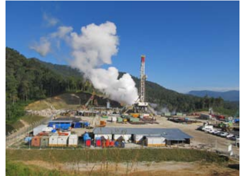
地热井掘进现场
