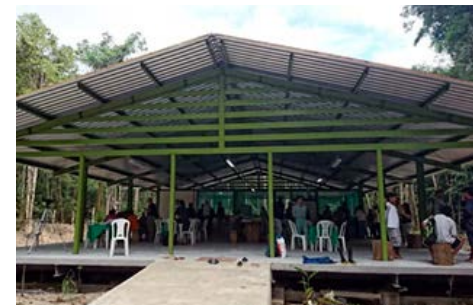
完成したフィールドステーション
