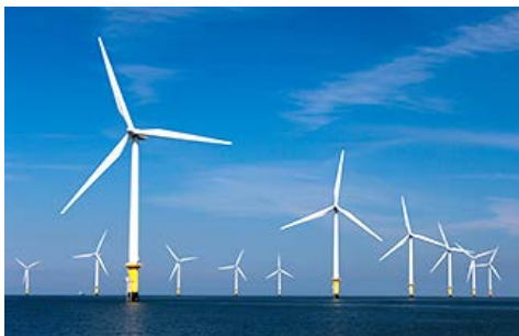
Butendiek 風力発電所
