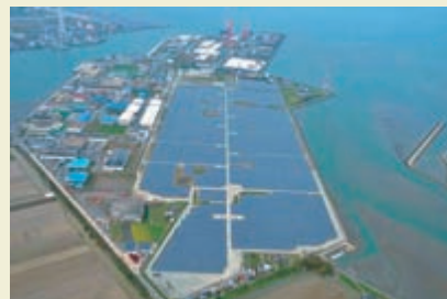
愛媛県の西条小松太陽光発電所
