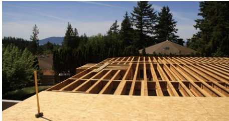
住宅专用结构材料,使用 Pacific Woodtech公司生产的单板层积材
