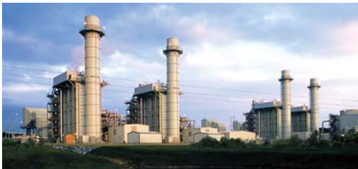
Kiowa power plant
