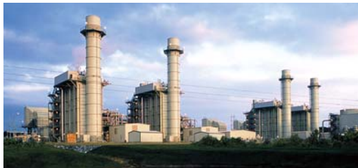
Kiowa power plant
