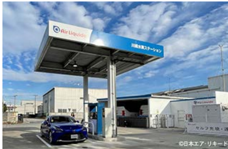
水素ステーション (日本エア・リキード合同会社川崎水素ステーション)
