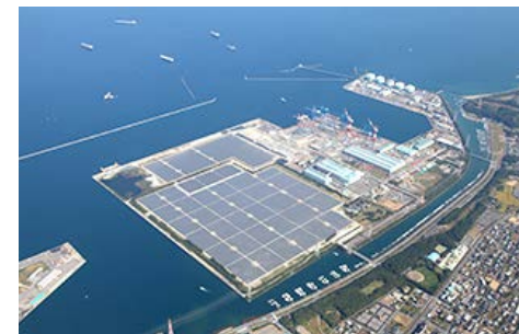
大分日吉原太陽光発電所
