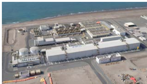
海水淡水化プラント
