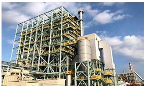
市原バイオマス発電所
