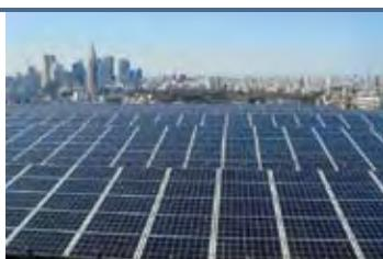
我公司在国内外致力于太阳能发电系统的普及，于2009年获得Ecosystem Japan Co.,Ltd.的协助，在伊藤忠商事东京总部大楼以及总部大楼相邻的CI 广场屋顶上安装了100KW的太阳能发电板（相当于一般住宅30户的用电容量）建立了“伊藤忠商事东京总公司太阳能发电站”。并在总部1楼、21楼、CI 广场占地内安装了显示装置，员工和相关人员可通过显示装置确认发电量，加深了对太阳能的理解。
