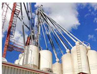
饲料的混合设施
