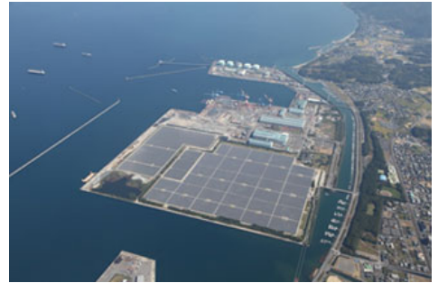
大分日吉原太阳能发电站全景
