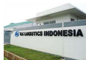
加拉璜工业园内的PT.ILC的办公室
