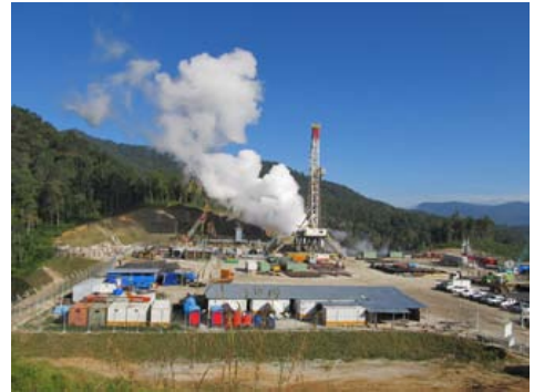
地热井钻探现场
