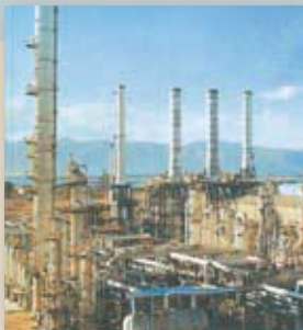
在阿尔及利亚建设的石化炼化一体化项目
