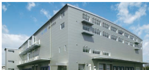
日本ACCESS 冰鲜物流中心
