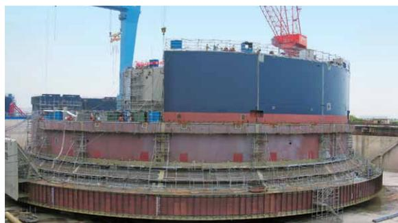
建设中的 SEVAN 型 (圆形) 浮体式石油开发设备
