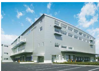
日本 ACCESS 物流中心外观
