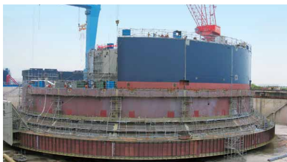
建设中的 SEVAN 型 (圆形) 浮体式石油开发设备
