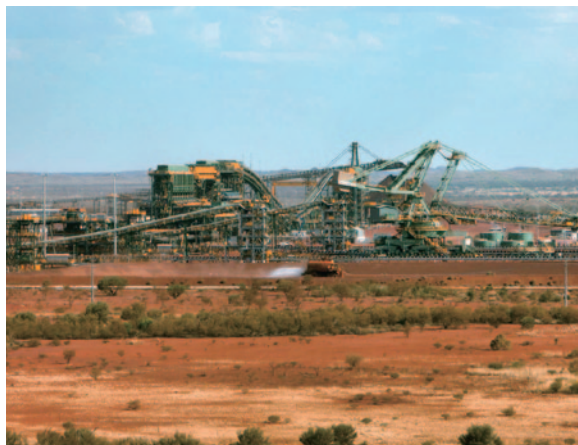
亚吉姆布莱巴铁矿山的矿石处理设备（必和必拓公司提供）
