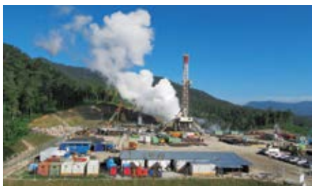
项目建设现场
