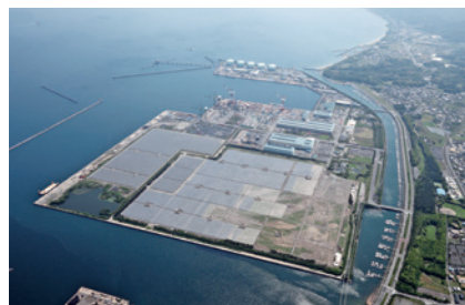
大分日吉原太阳能发电站全景
