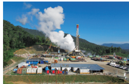
项目建设现场
