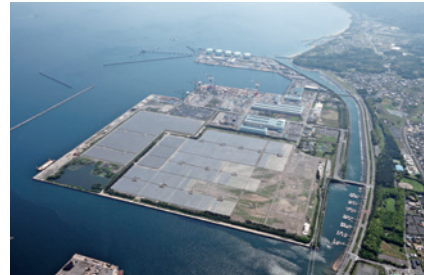
大分日吉原太阳能发电站全景
