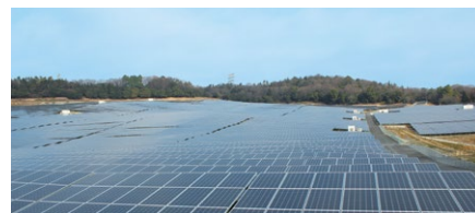
新冈山太阳能发电站（2017年1月，投入商业运转）
