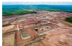
原油处理设施的建设现场
