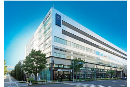
2012年翻新的总公司大楼
