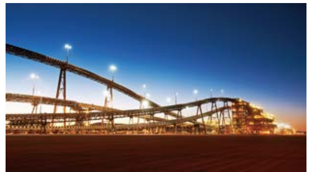
西澳大利亚铁矿山项目的矿石处理设备(BHP公司提供)
