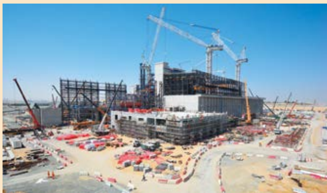
迪拜废弃物处理发电设施的建设情况
