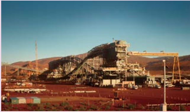
South Flank 铁矿山的选矿设备
