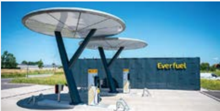
Everfuel 公司设置的加氢站
