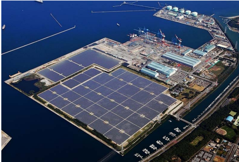
大分日吉原太阳能发电站全景
