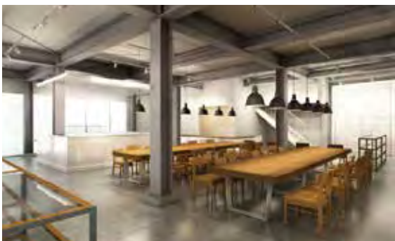
「ラカグ」の店内は昭和40年代に建てられた倉庫の味を生かし、モルタルの床やH形鋼をそのまま利用する計画（オープンは10月10日）。
