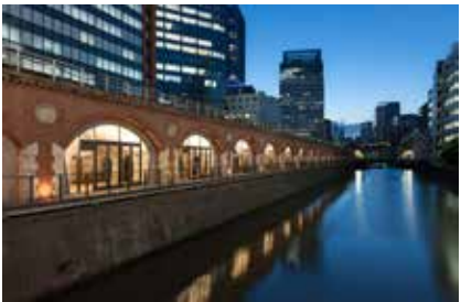
2. 「マーチエキュート神田万世橋」は、神田須田町エリアの歴史や記憶を残すために、レンガ高架橋の美しいアーチ空間を活かして設計された
