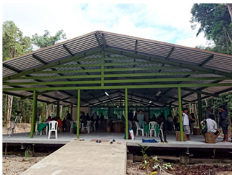
完成したフィールドステーション
