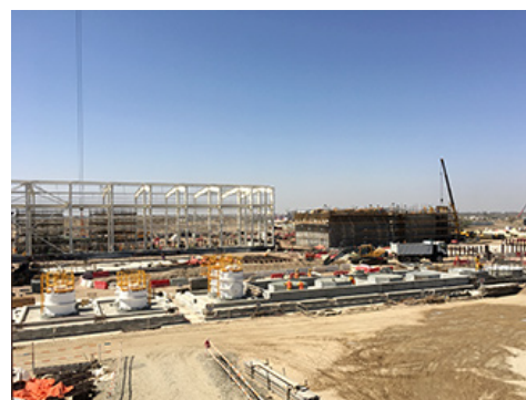
海水淡水化プラント（建設中）
