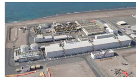
海水淡水化プラント
