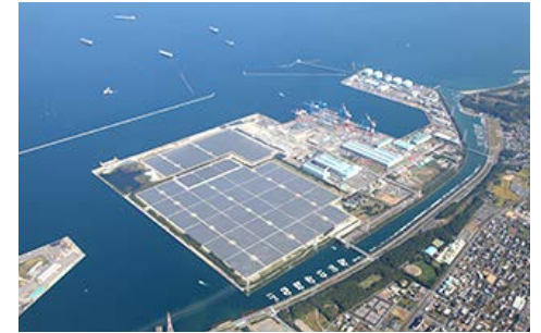
大分日吉原太陽光発電所
