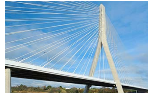
高炉スラグを使った建造物
