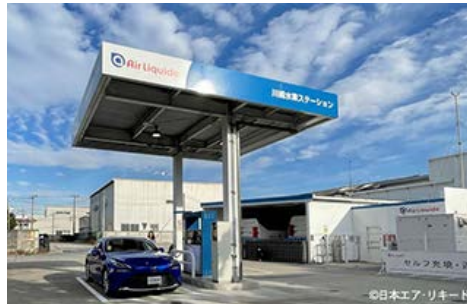
水素ステーション（日本エア・リキード合同会社川崎水素ステーション）
