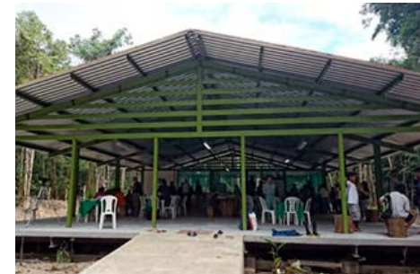
完成したフィールドステーション
