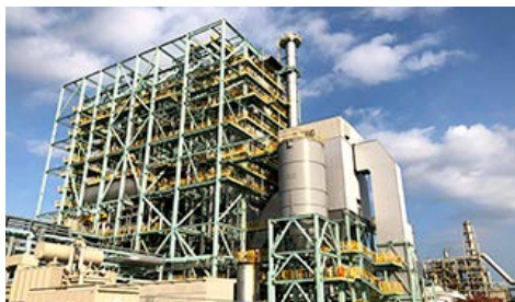
市原バイオマス発電所
