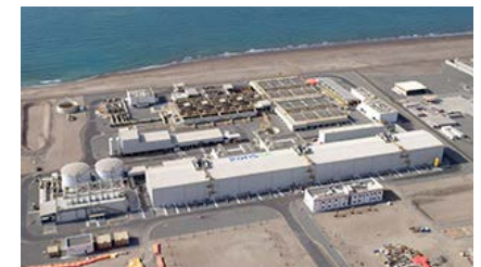
海水淡水化プラント
