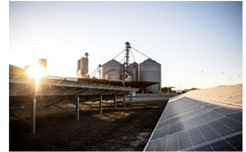
設置されている太陽光発電パネル
