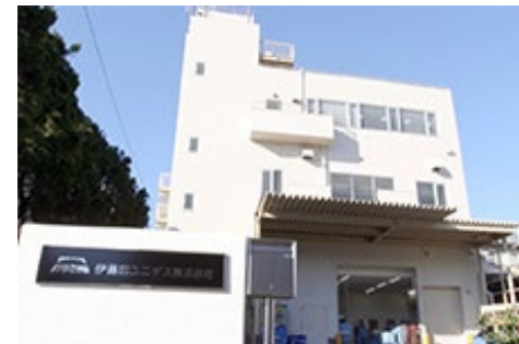
伊藤忠ユニダス(株)社屋(横浜市都筑区)
