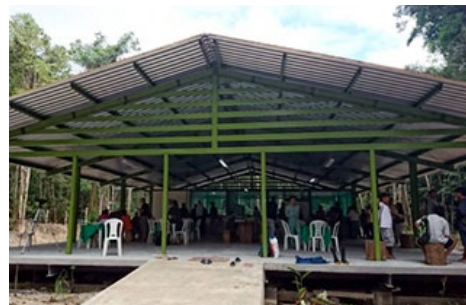
完成したフィールドステーション
