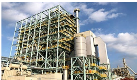
市原バイオマス発電所
