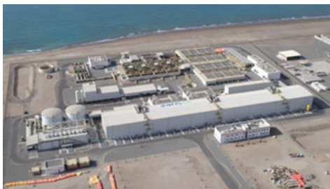
海水淡水化プラント
