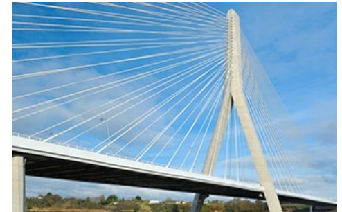
高炉スラグを使った建造物
