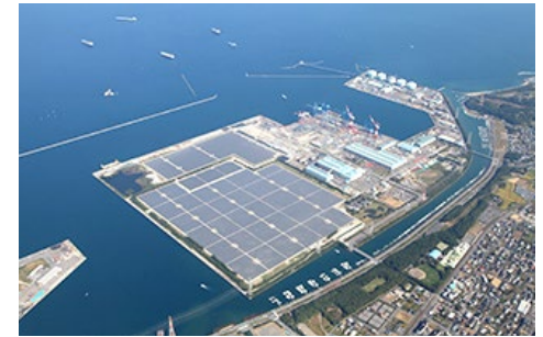
大分日吉原太陽光発電所
