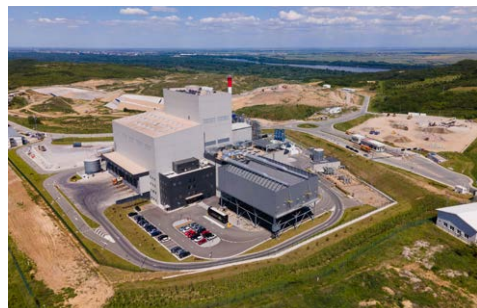
セルビア／ベオグラード 廃棄物処理・発電 PPP 事業サイトの航空写真
