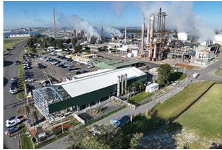
オーストラリアニューカッスルの MCI 社実証プラント (2025年1月撮影)
