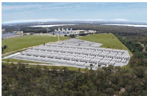
Akaysha 社開発中の豪州蓄電所プロジェクトの完成イメージ
