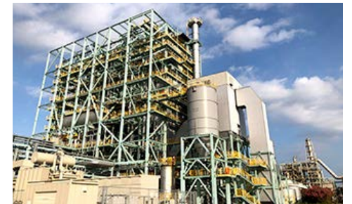
市原バイオマス発電所の外観
