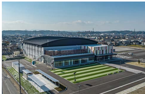
宮城県柴田町の総合体育館
