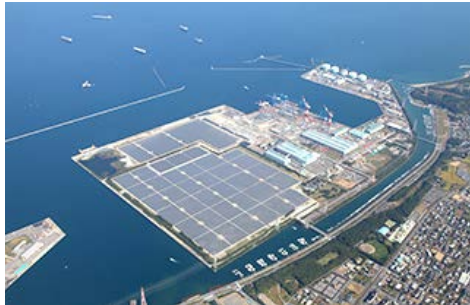
大分日吉原太陽光発電所
