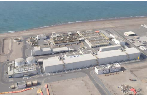
オマーン海水淡水化プラントの航空写真
