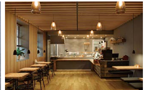
天井：ダイライト基材の不燃造作材「グラビオルーパー」 壁面：ダイライト基材の不燃化粧板「グラビオ」
