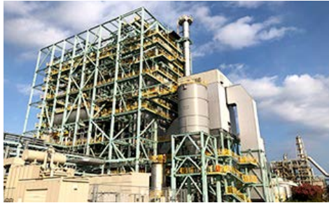
市原バイオマス発電所の外観
