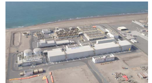
オマーン海水淡水化プラントの航空写真
