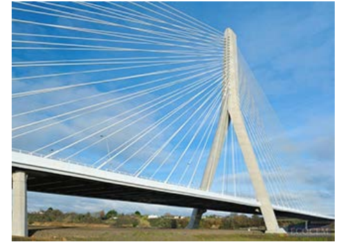
高炉スラグを使った建造物
