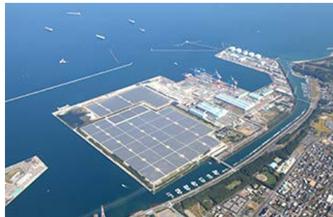
大分日吉原太陽光発電所
