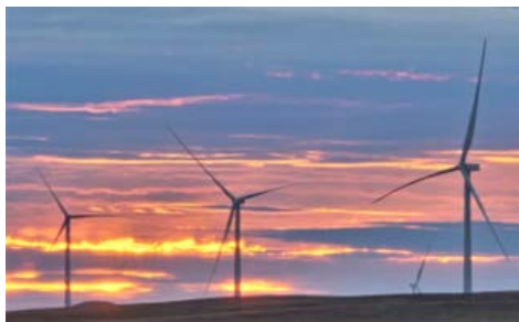
米国・ノースダコタ州 Bowman 風力発電所
