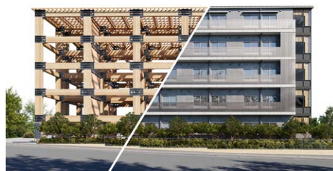
木造建築の伊藤忠商事女子寮
