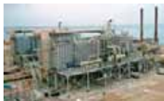
建設中の海水淡水化設備（サウジアラビア）
