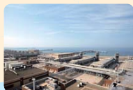
サウジアラビア 海水淡水化プラント リハビリ工事
