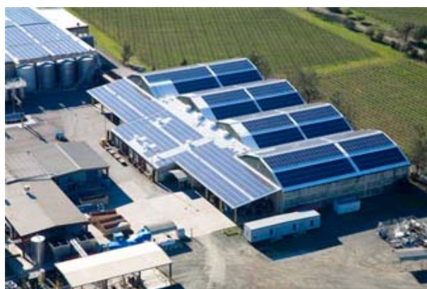
SolarNet販売・施工事例 カリフォルニア州Beringer Vineyards
