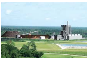
バイオマス発電所
