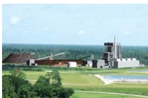
バイオマス発電所
