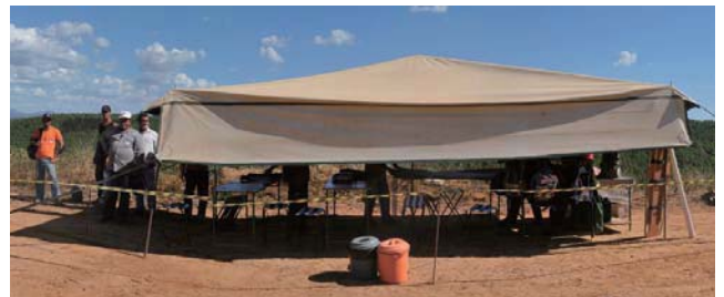
作業員達が休憩するためのテント
