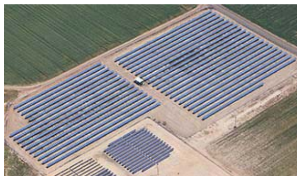
世界最大のワイナリー（米国カリフォルニア州）におけるStellar Energy（Soligent子会社）施工の太陽光発電システム
