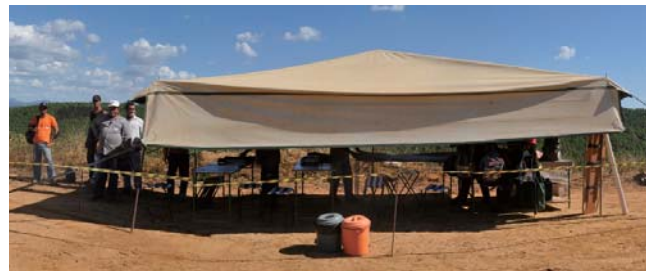
作業員達が休憩するためのテント
