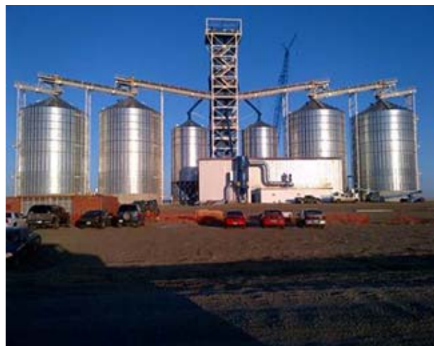
穀物エレベーター
