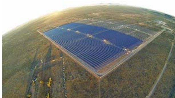
建設中の第一期入札分の75MWの太陽光発電システム
