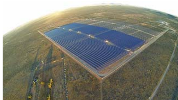
建設中の第一期入札分の75MWの太陽光発電システム
