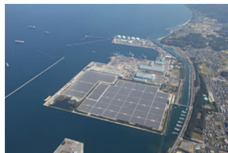
大分日吉原太陽光発電所全景
