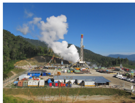
地熱井掘削現場
