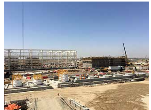
海水淡水化プラント（建設中）
