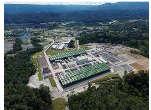
サルーラ地熱発電所1号機
