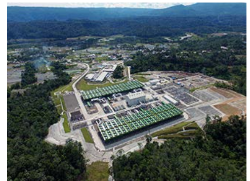
サルーラ地熱発電所1号機
