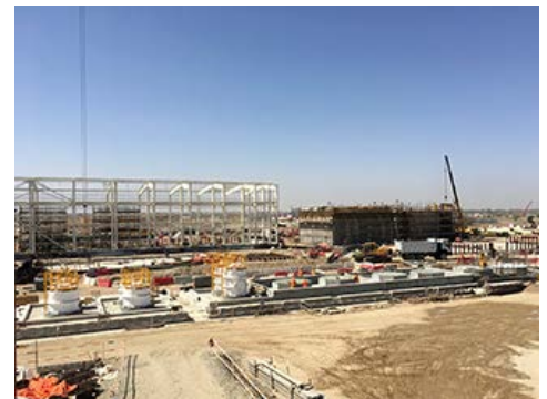
海水淡水化プラント（建設中）
