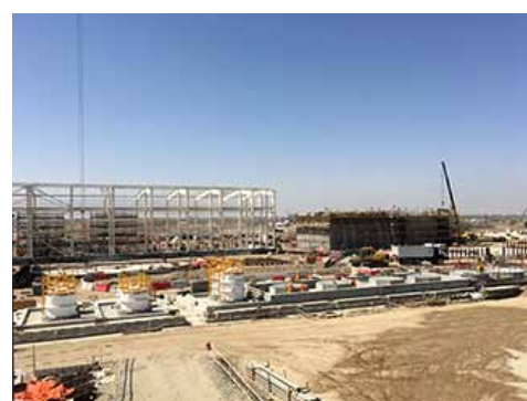
海水淡水化プラント（建設中）
