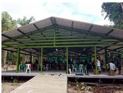
完成したフィールドステーション
