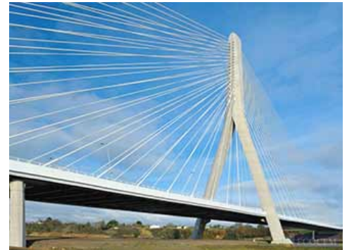
高炉スラグを使った建造物
